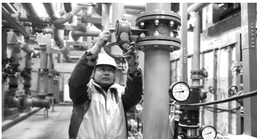
工作人员正在调试供暖设施。
